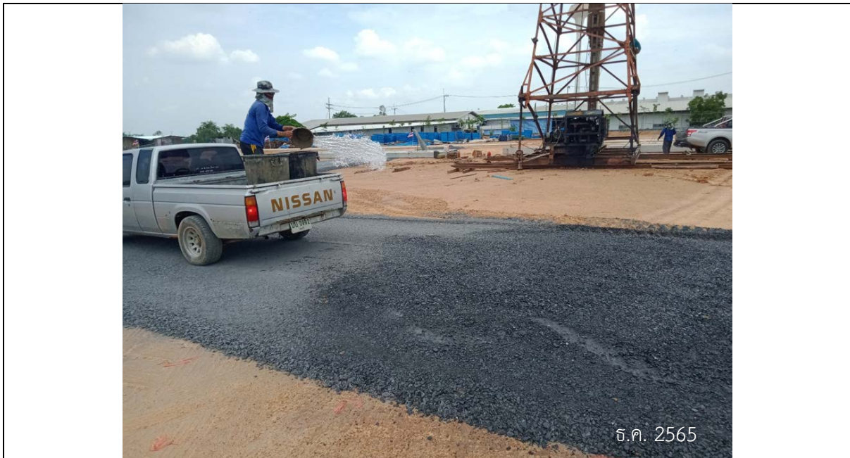
รูปที่ 2-5 การฉีดพรมน้ำบริเวณพื้นที่ก่อสร้าง
